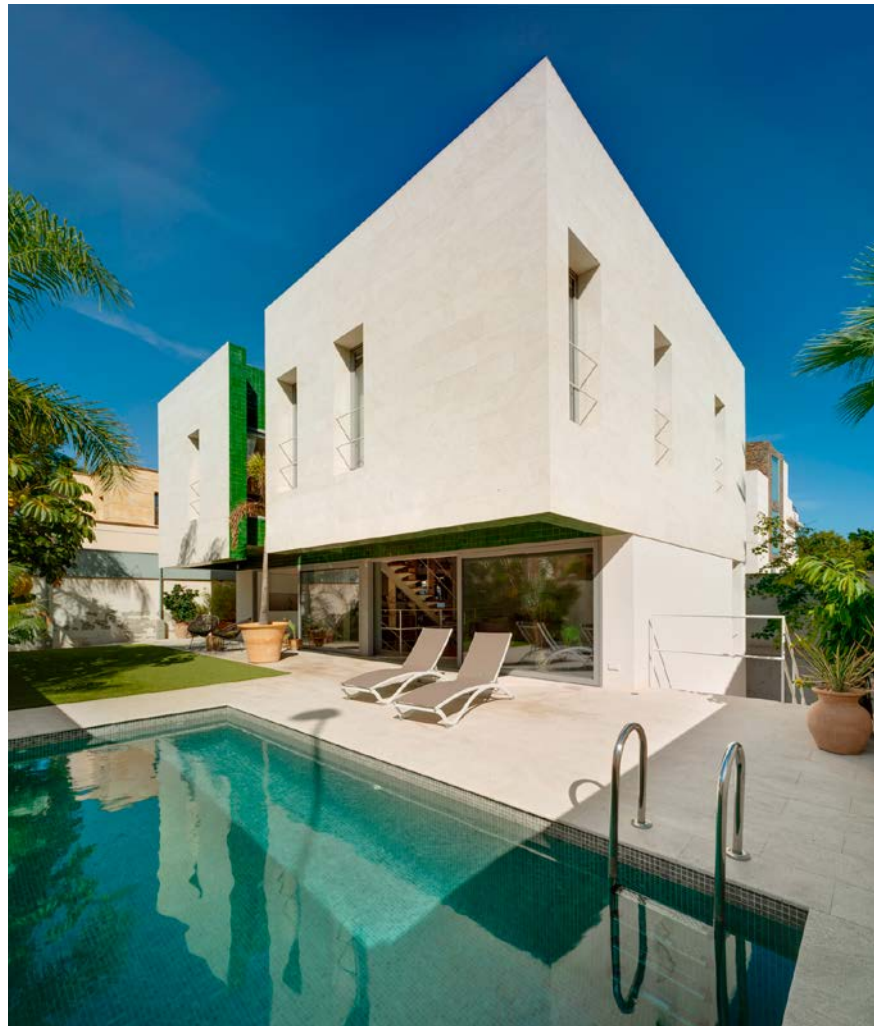
Maison individuelle, Alicante, Spain .
